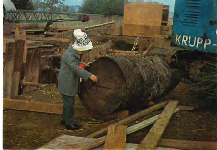
Abbildung 12 Gehobenes Stammstück (Probe I a) in der Roncallistraße
