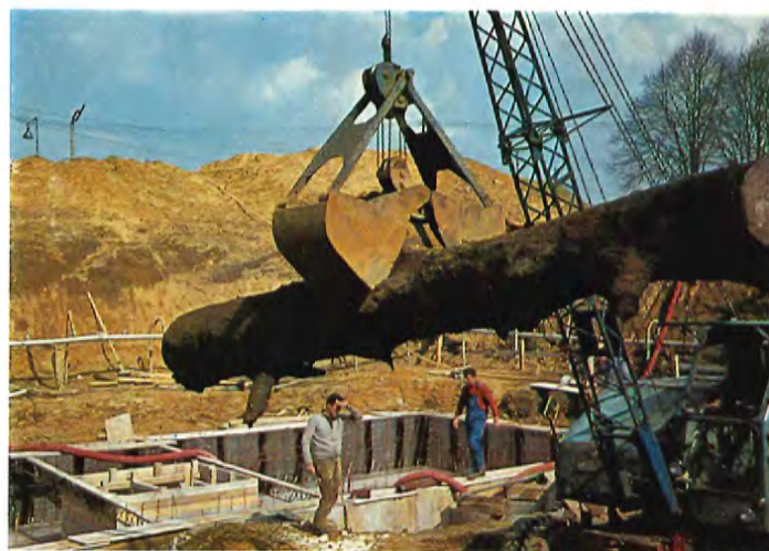
Abbildung 14 Das kronwärtige Stammstück wird aus der Baugrube an der Roncallistraße gehoben
