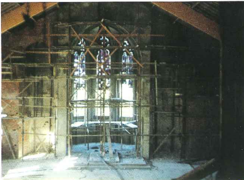
13 Das neue erweiterte Kirchenschiff wird an den Chorbereich angesetzt
