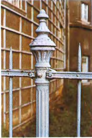
75 Gitter-Pfosten hinter dem ehemaligen »Konsum«
