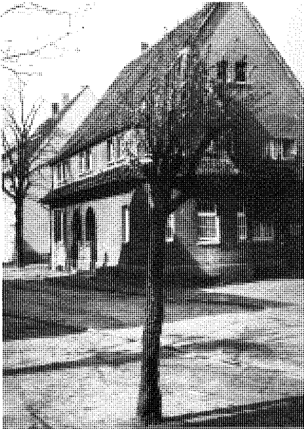
22 Haustyp 5 an der Moltkestraße (heute: Oberlarer Straße) Nr. 24/26 nach dem 2. Weltkrieg vor der Asphaltierung der Straßen
