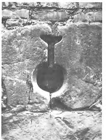
171–178 Vermauerte Schmuckdetails (barock) des historischen Baus von 1550 und ein Toilettenstein aus der ursprünglichen Bauperiode.
