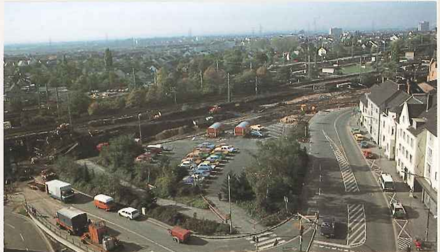
3 Bau des Theodor-Heuss-Ringes entlang der Sieg-Bahnstrecke
