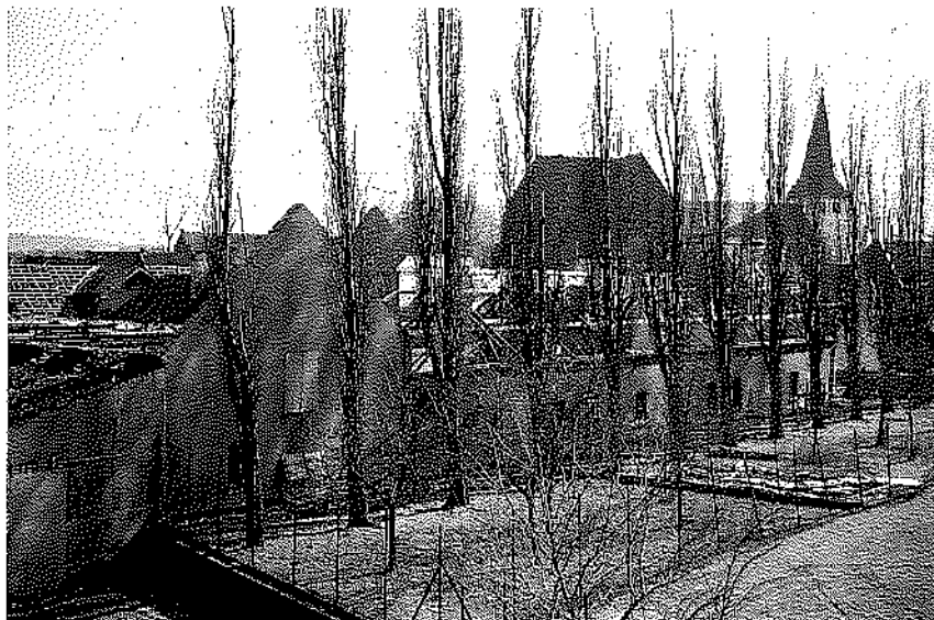
11 Abriß des Schirmhofes für den Bau des neuen Sieglarer Rathauses
