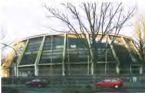
Rundturnhalle mit Asbestdecke
