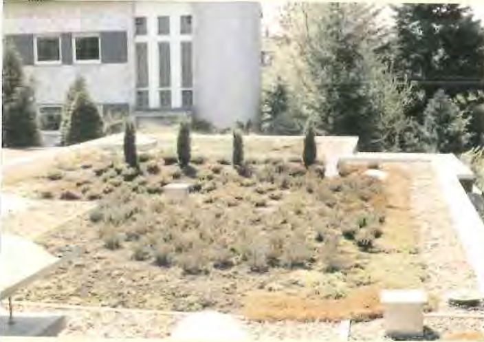
2. Das Dach von Josef Schnüttgens Büro und Lager nach der Fertigstellung im September 1987
