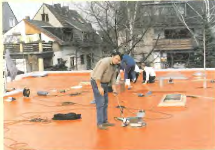
1. Frühjahr 1987. Dachdeckermeister Josef Schnüttgen dichtet sein Dach in Spich ab
