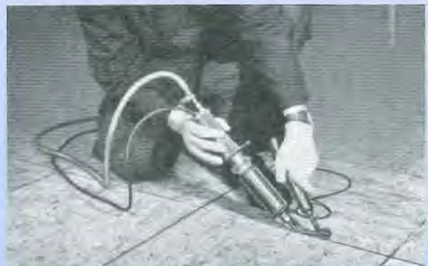
Mipolamverschweißung bei der Bodenverlegung
