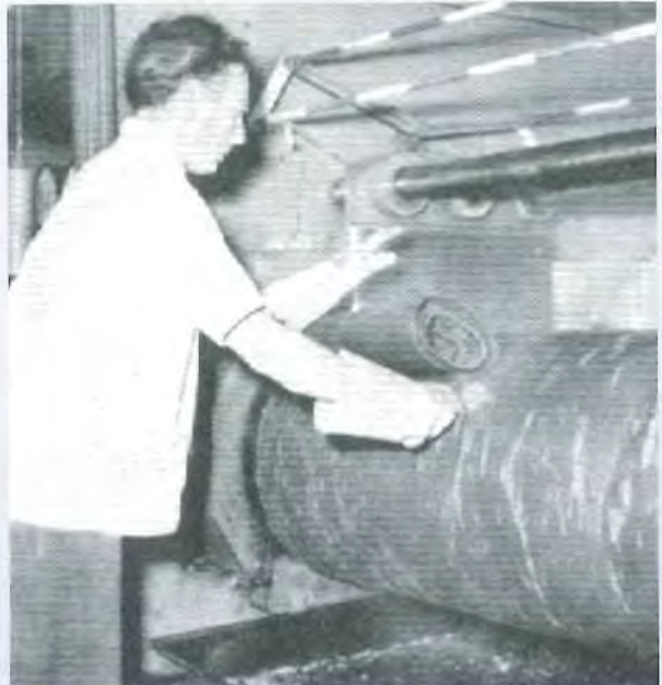
Mischwalzwerk einer PVC-Mischung
