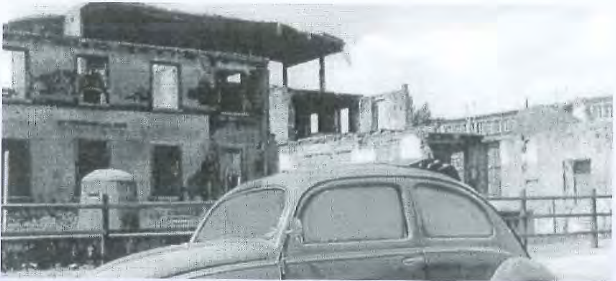
Zerstörtes Verwaltungsgebäude am 29. 2. 1945
