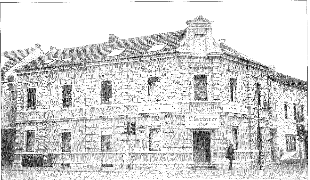
Die Gaststätte „Oberlarer Hof“ nach der letzten Restaurierung.
