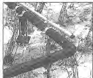
DAS KLARE ABWASSER rieselt von oben durch ein Rohrsystem gleichmäßig auf die Pflanzenkläranlage, die auch bei Frost funktioniert. (Bilder: Del Din)
