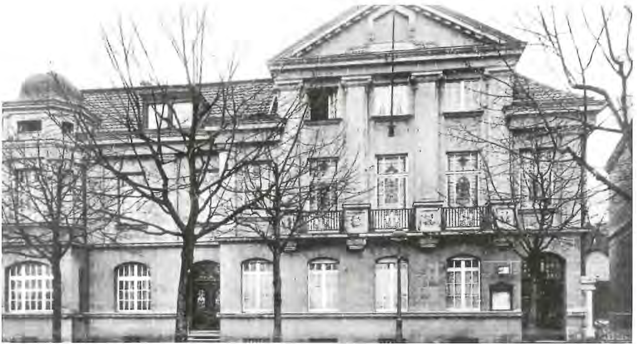
Bürgermeisteramt Poststraße, wie es bis zur Zerstörung 1944 bestand
