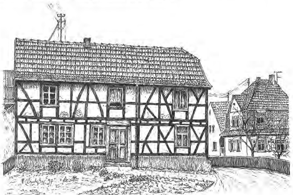
Wohnhaus des Hammerhofes, Zustand ca 1960
