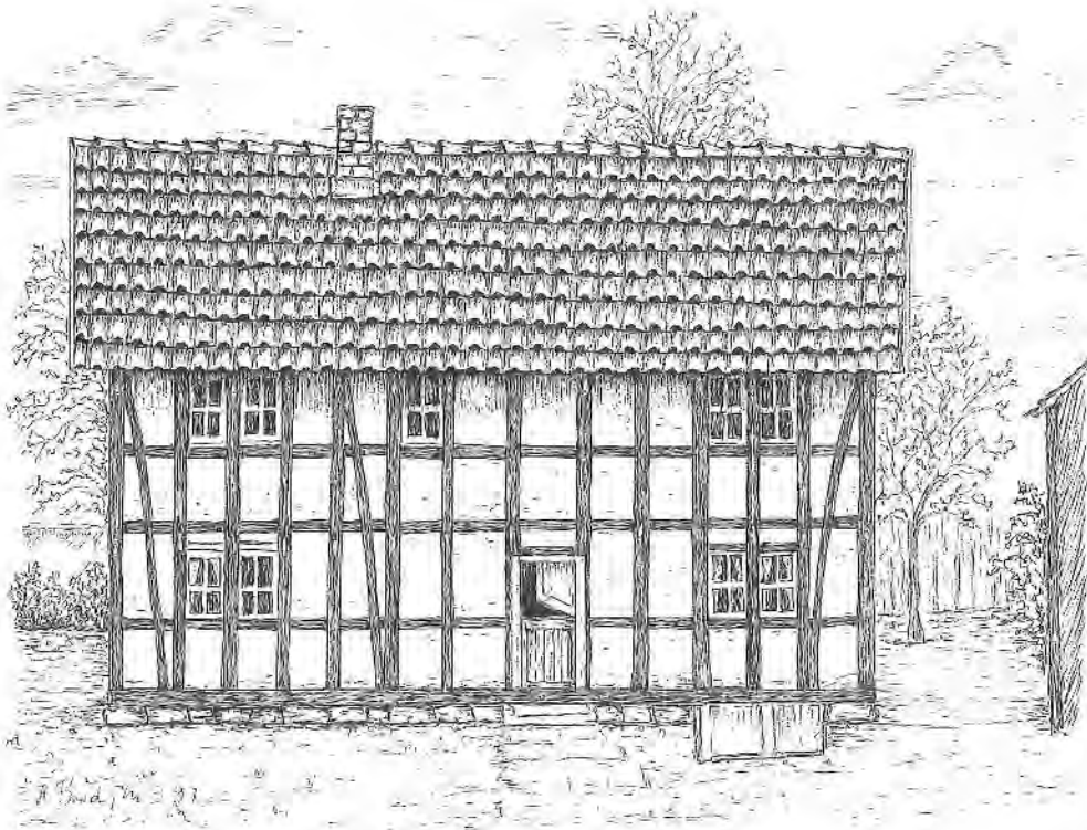
Wohnhaus des Turmhofes von 1698, Zustand um 1900, erst in jüngster Zeit weggenommen
